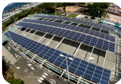
IN07 Implantación de plantas solares en los centros de aparcamientos
