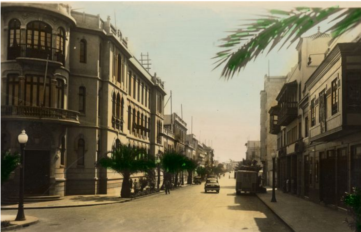
El primer edificio de la derecha era el Cine Avenida. Años '40. Fedac.
